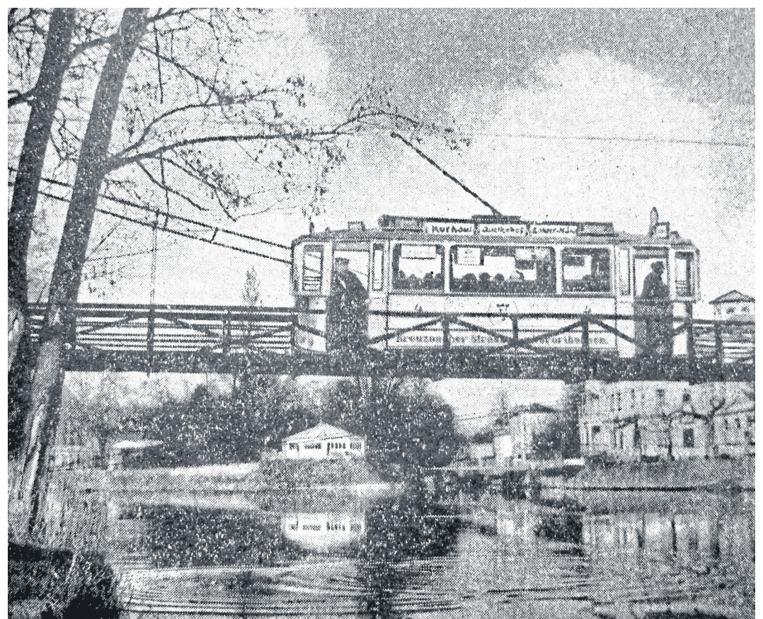
Die neue „Straßenbahnlinie 4" auf der Hängebrücke.
